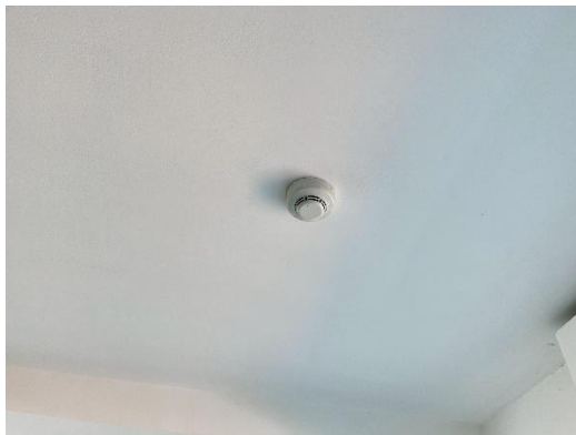
รูปที่ 3-29 อุปกรณ์ตรวจจับควัน ตรวจจับความร้อน และไฟฉุกเฉินอัตโนมัติชนิดแบตเตอรี่แห้ง
