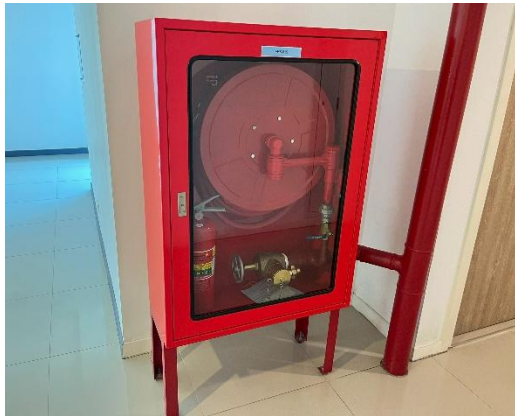
รูปที่ 3-28 ตู้เก็บสายฉีดน้ำดับเพลิงพร้อมอุปกรณ์ (Fire Hose Cabinet : FHC)
