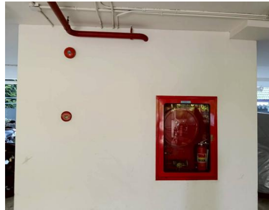
รูปที่ 3-28 ตู้เก็บสายฉีดน้ำดับเพลิงพร้อมอุปกรณ์ (Fire Hose Cabinet : FHC)
