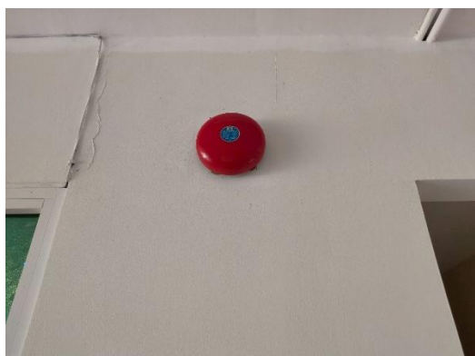
รูปที่ 3-30 อุปกรณ์แจ้งเหตุไฟไหม้เครื่องส่งสัญญาณเตือนอัคคีภัย (Fire Alarm Bell) และแผงควบคุม (Manual Station)
