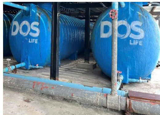
รูปที่ 3-11 ถังเก็บน้ำชั้นใต้ดิน และถังเก็บน้ำชั้นดาดฟ้า
